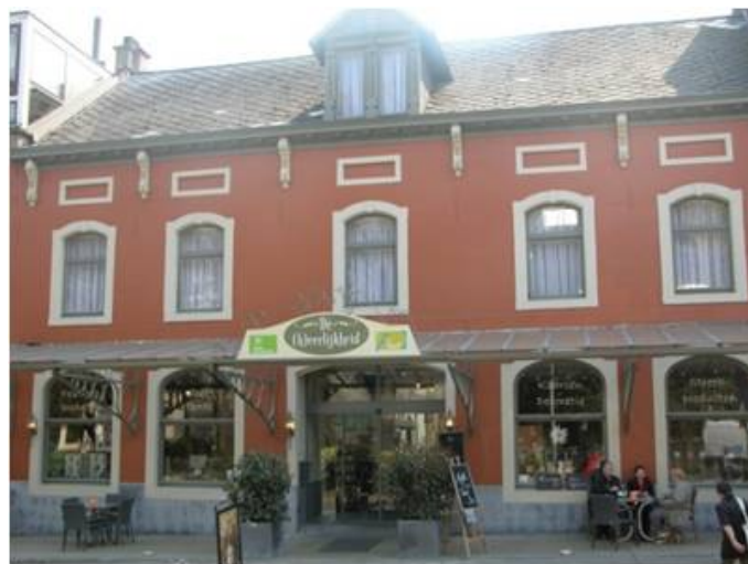
Foto: gebouw na renovatie.
